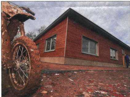
An der Motocrossstrecke in Leubsdorf ist in diesem Jahr ein Mehrzweckgebäude gebaut worden. Jetzt fand die Einweihung statt.
